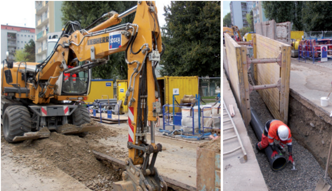
Chantier de la rue Charles Péguy
