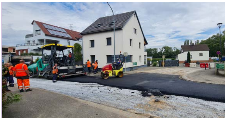
> Travaux, rue de Hésingue
